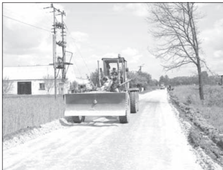
Droga w Kaźmierce w trakcie budowy
