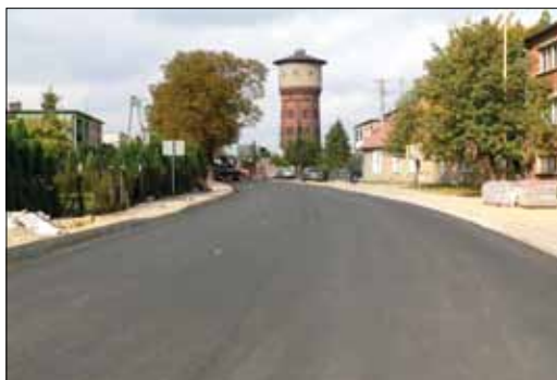
Nowa nawierzchnia ul. Marszewskiej w Pleszewie
