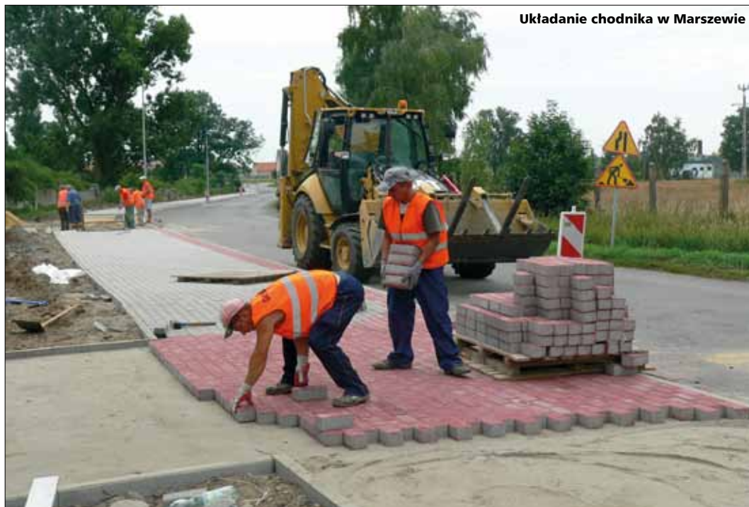
Przebudowa drogi powiatowej Pleszew - Czermin - Grab (2010 - 2011r.)
