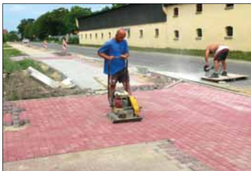
Budowa chodnika w Czerminie
